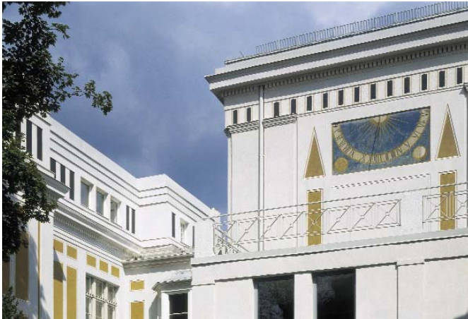
Aussenansicht Museum Villa Stuck, Foto: Jens Weber
